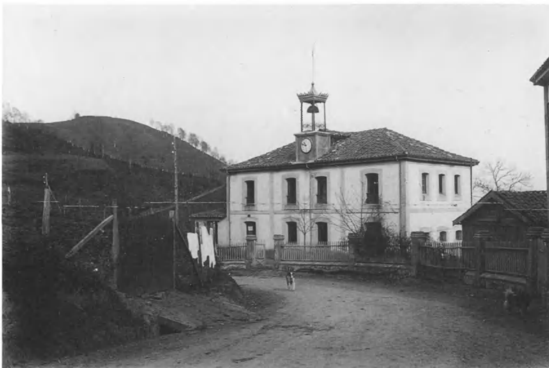
Lliberdón/Libardón (Colunga): Casa-escuela, hacia 1914. Una placa colocada en la fachada recuerda a los promotores de su construcción: «Esta casa escuela fue donada / al pueblo por los hijos de esta / parroquia residentes en / América con la cooperación /del vecindario / Año 1903»; 10 × 15 cm.
